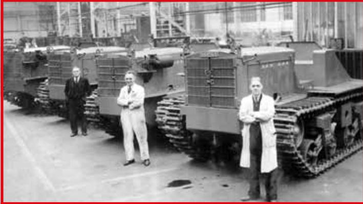
Panzer zu Traktoren: Nach dem Zweiten Weltkrieg wurden britische Sherman-Panzer zu Traktoren umgebaut. Diese Shervick-Traktoren wurden in Afrika eingesetzt und versagten dort jämmerlich. (Foto: © Tyne & Wear Archives & Museums)
